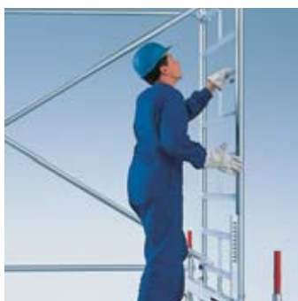
Accès par l'intérieur de la tour.
