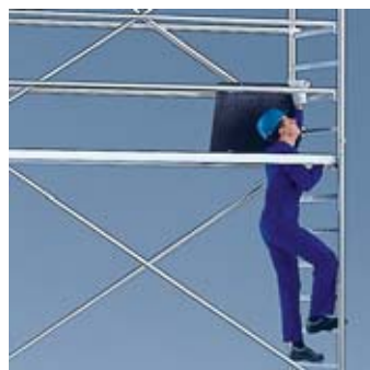
Accès par plancher à trappe.
